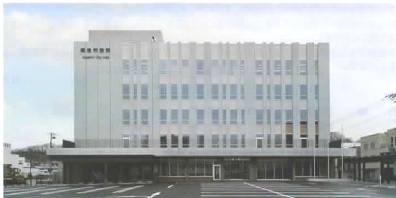
▲庁舎外観：高断熱材やLow-E 複層ガラスを使用し、エネルギー消費を抑制した環境に優しい庁舎です。
